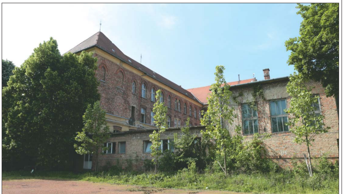
A kicsi, lapostetős épületet elbontják, helyére új szárny épül, amelyben az étkező és az irodák kapnak helyet
