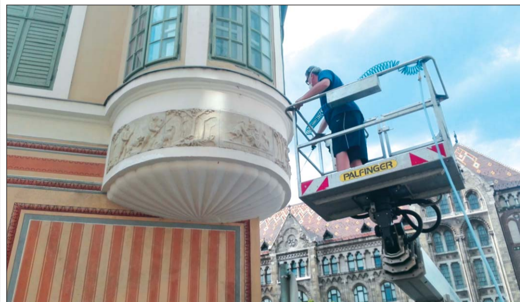
Magasnyomású levegővel tisztítják az épületeket
