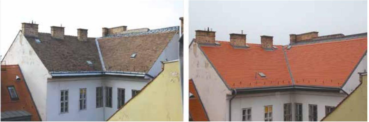
Úri utca 36. tetőfelújítási munkák
