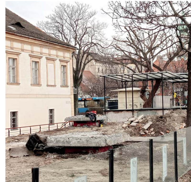
A legendás terasz jelenleg építési terület
